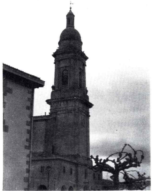
La torre de Alegría-Dulantzi, la más esbelta de la Llanada alavesa, 62 metros de altura. 1789. Oreitia es el ensayo que se agiganta en Dulantzi.
